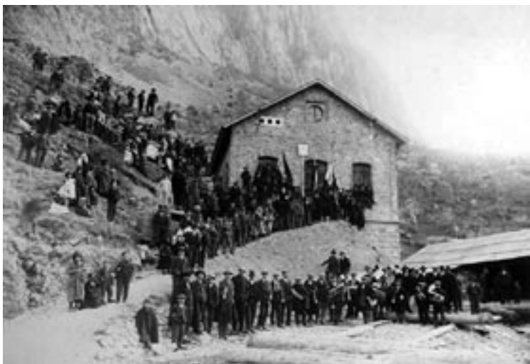
Έναρξη λειτουργίας του πρώτου υδροηλεκτρικού εργοστασίου του συνεταιρισμού SECAB, το 1913
