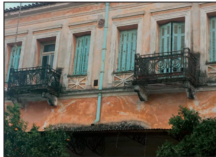
Ανακαίνιση του κτηρίου Σπυρόπουλου
